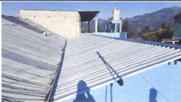
Foto 3: Sustitución de capote de lámina para lámina troquelada aulas de Primaria
