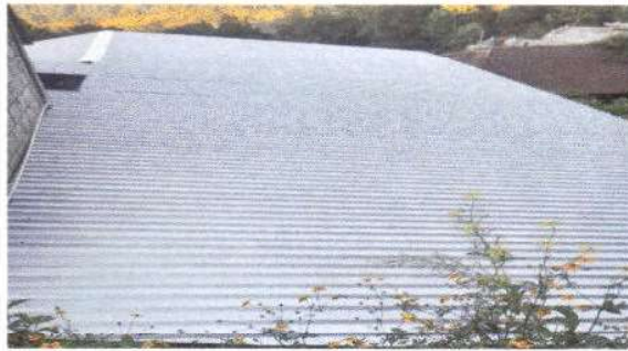
Foto1: Sustitución de lámina, por lamina troquelada aluzinc calibre 26 Modulo Parvulos
