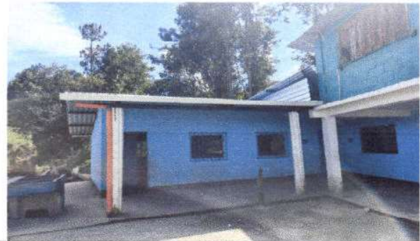
Foto 2: Sustitución de lámina, por lamina troquelada aluzinc calibre 26 Modulo Parvulos
