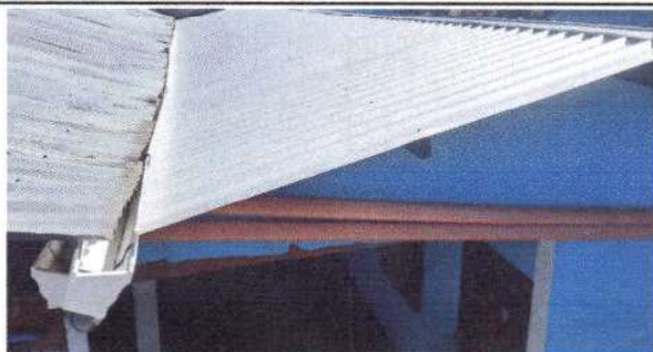
Foto 5: Sustitución de canal de pvc Modulo Primaria
