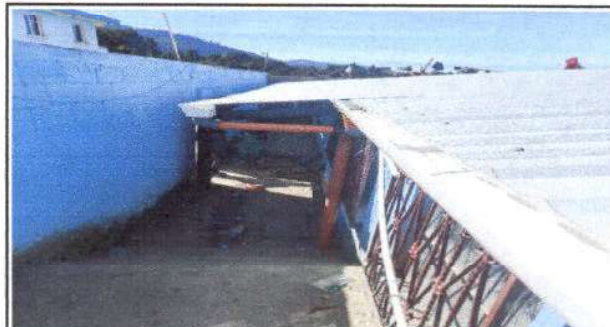
Foto 6: Sustitución de soporte o pescante de metal para canal Modulo Primaria
