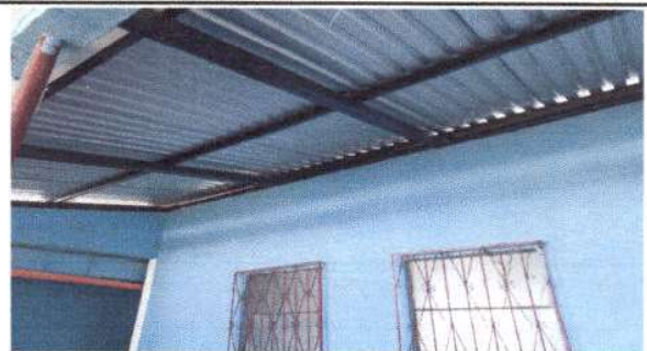
Foto 4: Sustitucion de soporte de madera por metal aulas de Primaria
